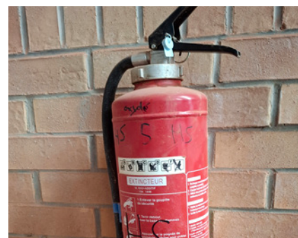
Remplacement des extincteurs
